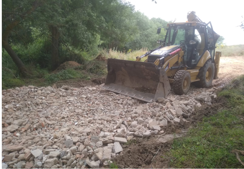
Grava Mezcla 80 -150 mm
